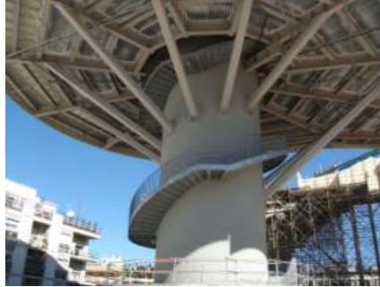
Figura 6. Plataforma de acero del restaurante. Conectores de compresión diagonales ayudados por cremallera dentada
