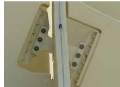
Figura 11. Varillas encoladas, colocación de los conectores y montaje en obra
