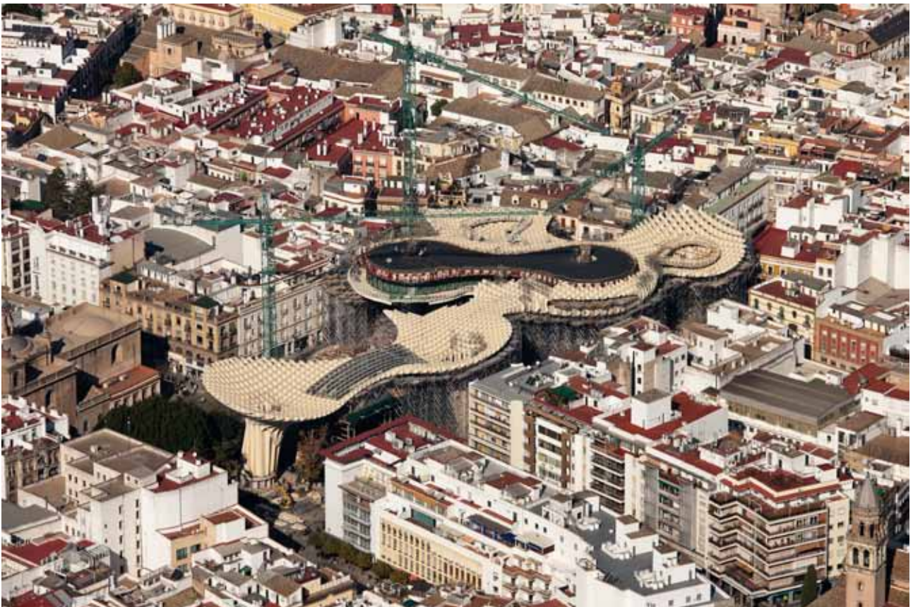
Vista aérea del edificio, en su fase final, insertado en la trama urbana
