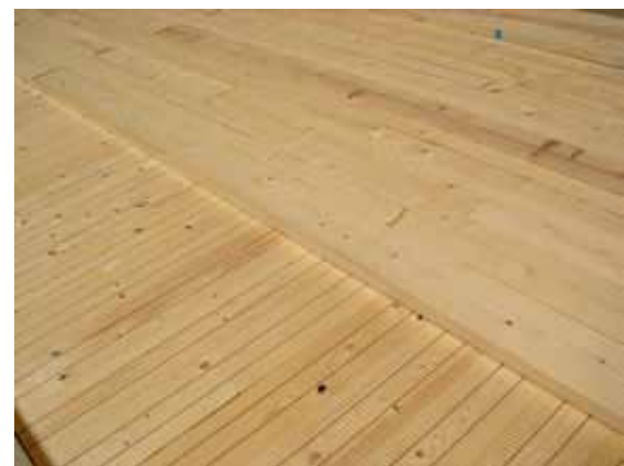
Armado de paneles contralaminados en la prensa
