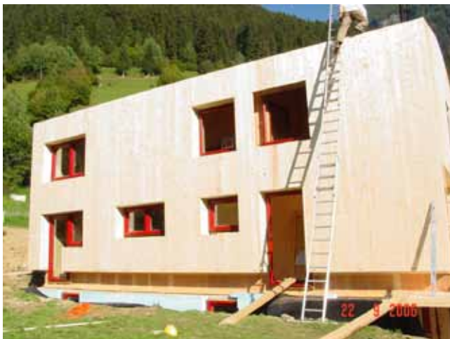
Construcción de una vivienda unifamiliar con madera contralaminada
