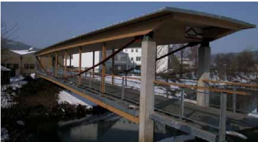
Pasarela peatonal en Feldbach
