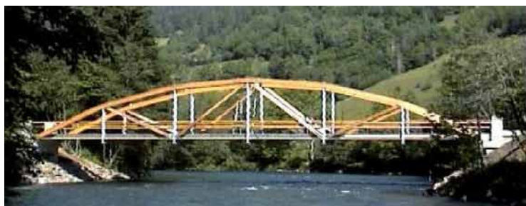
Puente de WandRitsch
