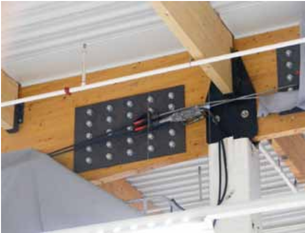
Figura 10: Fase de tesado de los cables, se puede observar el gato de tesado, y detalle de la placa de anclaje.
