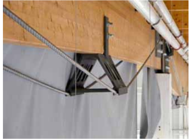
Figura 12: Detalle del gato de tesado y elemento desviador de los cables. El diseño final del desviador fue realizado por el departamento técnico de Mekano 4.
