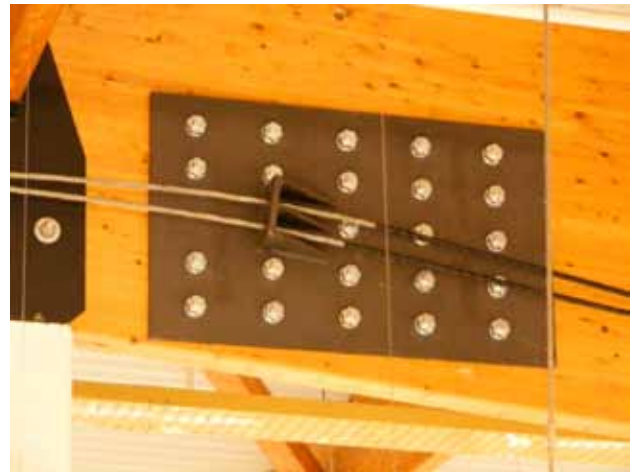
Figura 10: Fase de tesado de los cables, se puede observar el gato de tesado, y detalle de la placa de anclaje.
