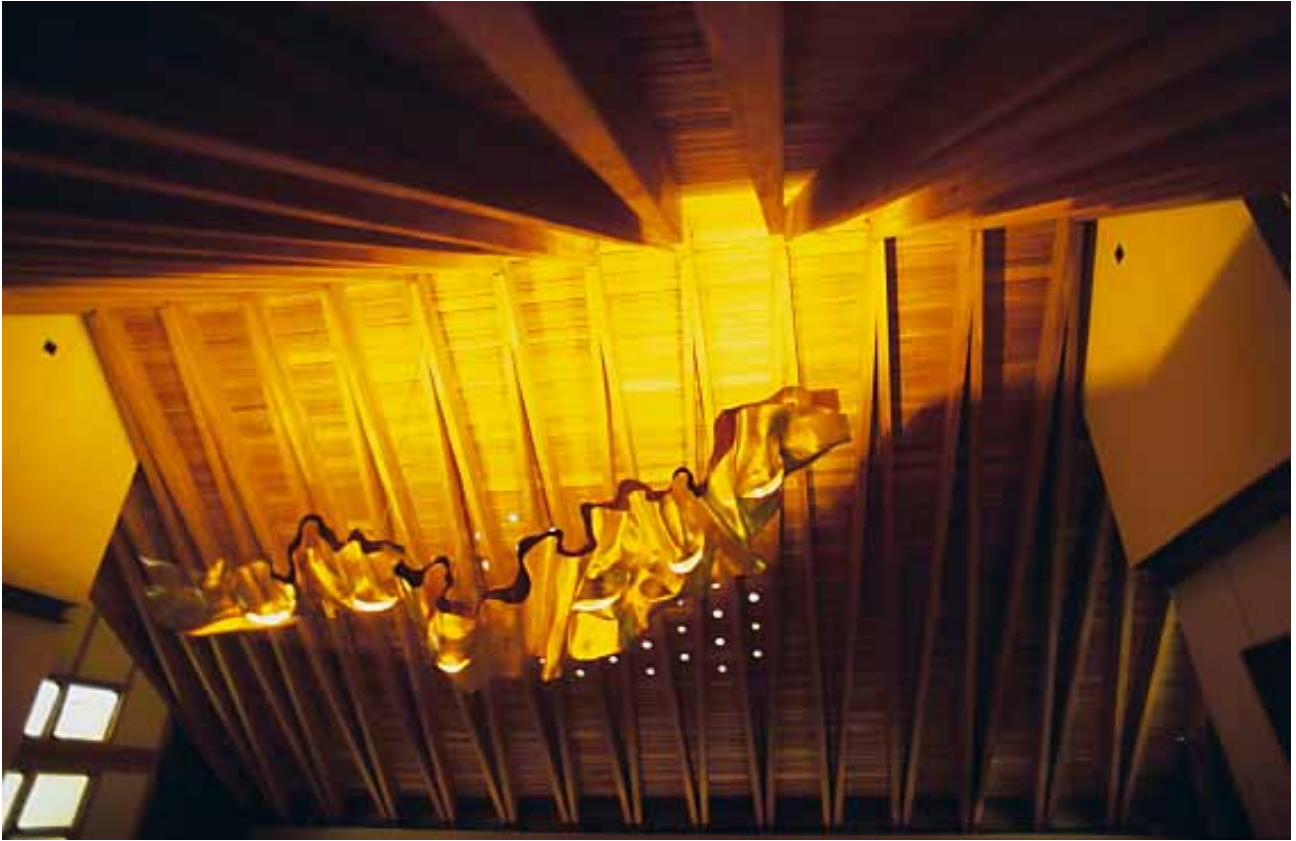
Sala central del Palacio de Botines (de Antonio Gaudí) mencionada en el artículo, con estructura de madera laminada, que en principio se intentó hacer de castaño y finalmente se ejecutó en roble por falta de suministro en aquel momento
