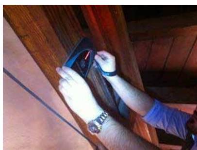
Fig. 23. Utilización de pachómetro para detectar la presencia de pernos y clavos en la estructura.
