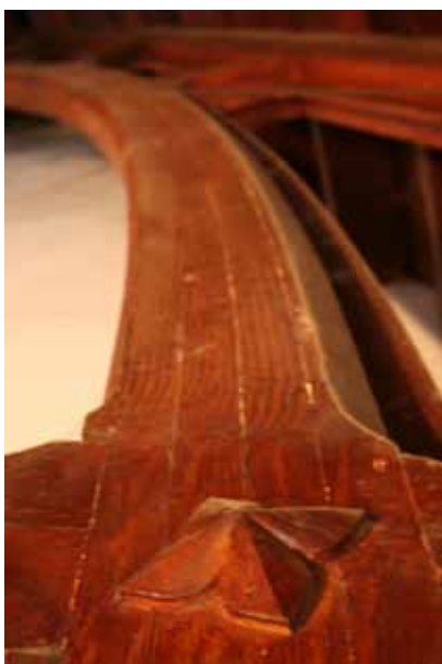
Fig. 06. Arco con madera laminada.
