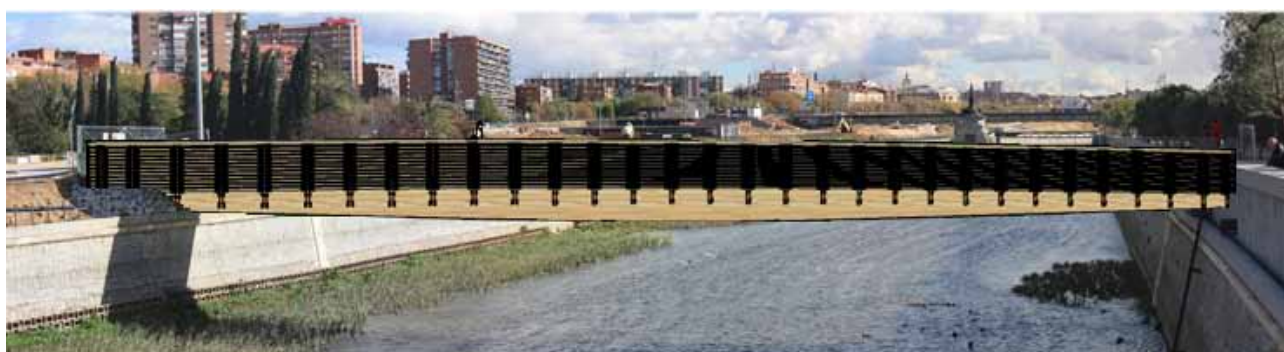
Pasarela de madera
