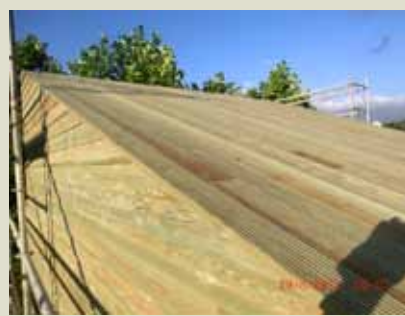
Montaje de cubierta inclinada e impermeabilización mediante EPDM en cubierta plana pendiente 0.
