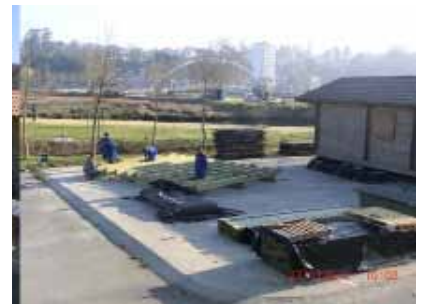
Replanteo y comienzo de montaje de la estructura por parte de los alumnos del CIPF A Xunqueira.
