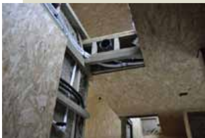
Los paneles interiores están constituidos por un doble entramado de montantes con horizontales a ambos lados, dispuestos cada 40,9 cm y sirviendo de soporte a los tableros OSB de 12,5 mm que configuran el acabado por ambos lados.
