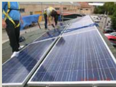
Revestimiento de madera en cubierta inclinada sobre entramado flotante para el anclaje de sistemas de captación solar. Anclaje de paneles fotovoltaicos que proporcionan al edificio de autonomía energética.
