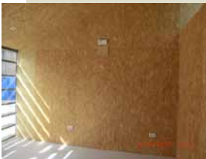
Montaje de paneles portantes de entramado ligero.
