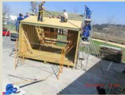
Montaje de cubierta inclinada e impermeabilización mediante EPDM en cubierta plana pendiente 0.
