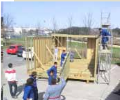
Montaje de paneles portantes de entramado ligero.
