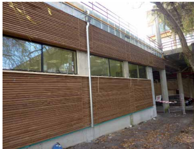
Madera termotratada en fachada oeste
