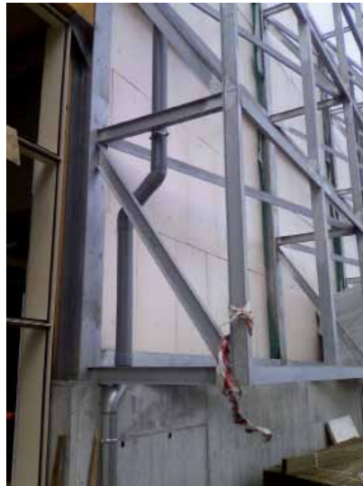
Subestructura de sujeción de las pirámides
