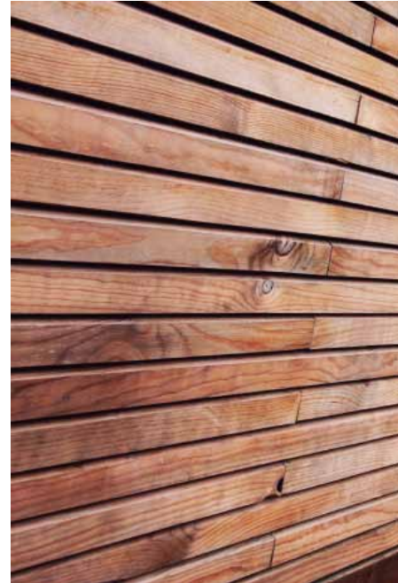
Celosías de gran formato en planta baja
