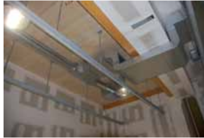
Proceso constructivo tableros CLT
