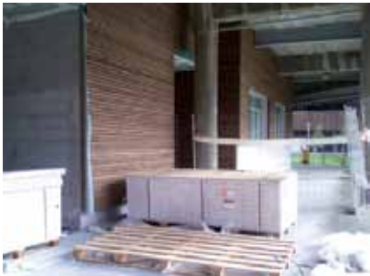
Entablado madera termotratada en el acceso
