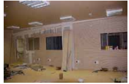
Proceso constructivo paneles acústicos
