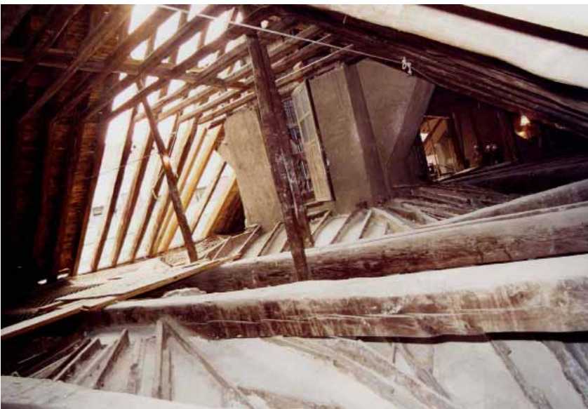
Proceso de restauración de la estructura de madera
