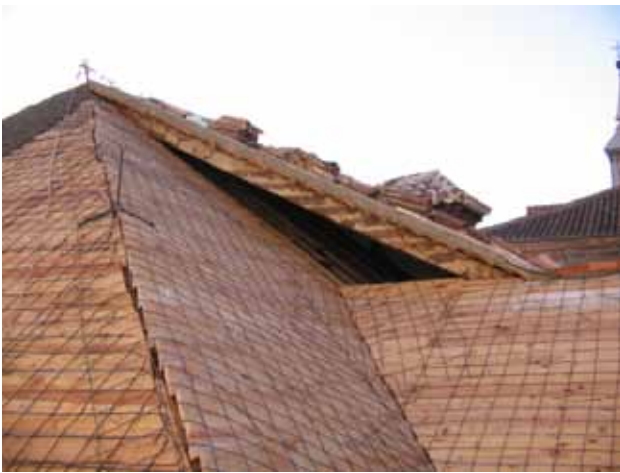
Proceso. Nueva ripia, mallazo conectores, impermeabilización y capa de compresión
