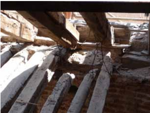
Antiguas reparaciones del alero
