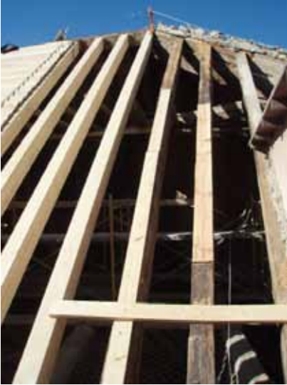
Prótesis y sustitución de pares de madera del faldón de cubierta de la Sacristía
