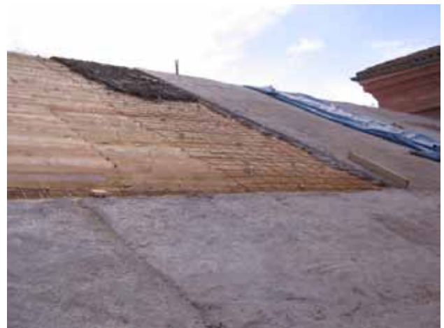
Proceso. Nueva ripia, mallazo conectores, impermeabilización y capa de compresión
