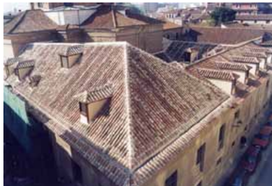
Exterior. Cubierta terminada de la cubierta
