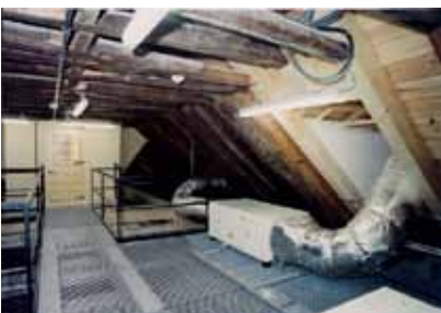
Pasarela trámex en el bajocubierta de la Sacristía
