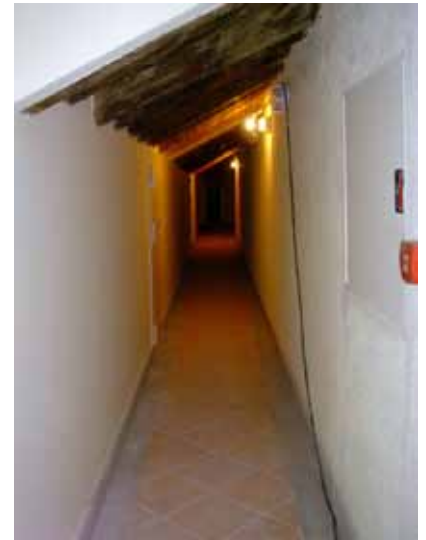
Entretecho y tabique de pladur para independizar las máquinas climatizadoras
