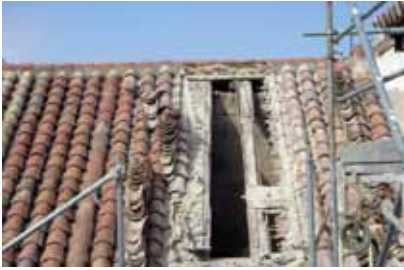
Desmontaje de las tejas curvas antiguas
