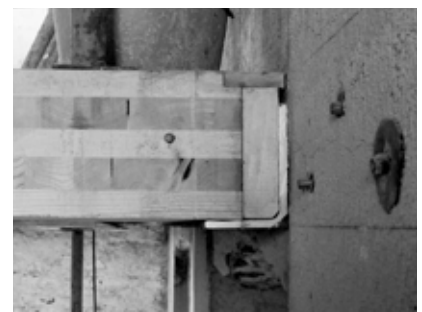
detalle apoyo de panel de madera contralaminada
