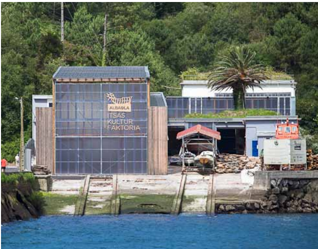
Factoría en Pasaia, construida especialmente para la restauración del San Juan
