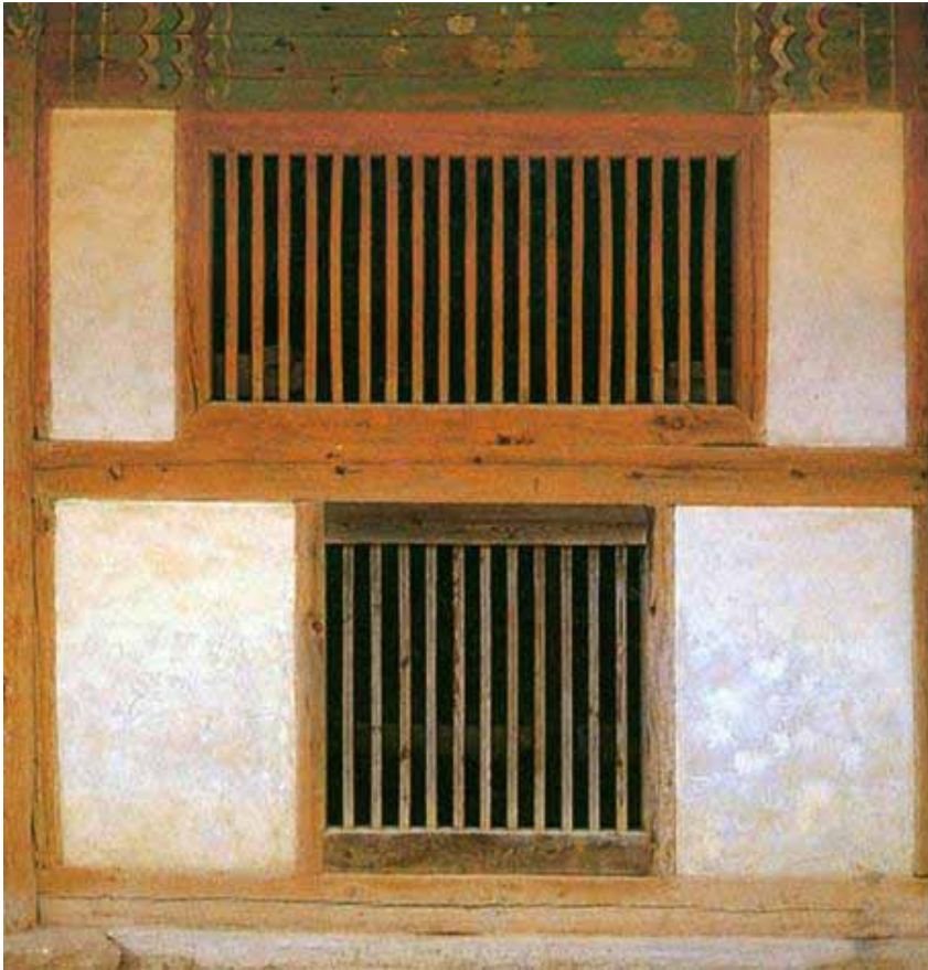
Ventanas de ventilación que ajustan su flujo de aire mediante los barrotes
