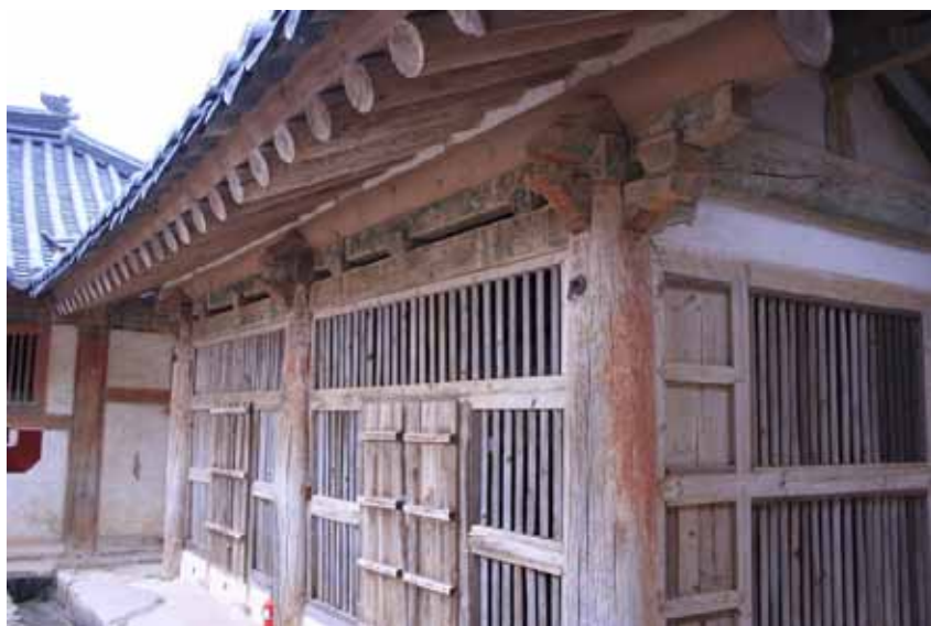
Ventanas de ventilación
