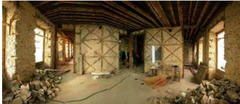
Fig. 9. Obras de rehabilitación de una Gaiola
