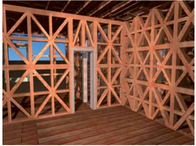
Fig.3. Reconstrucción de gaiola pombalina.
