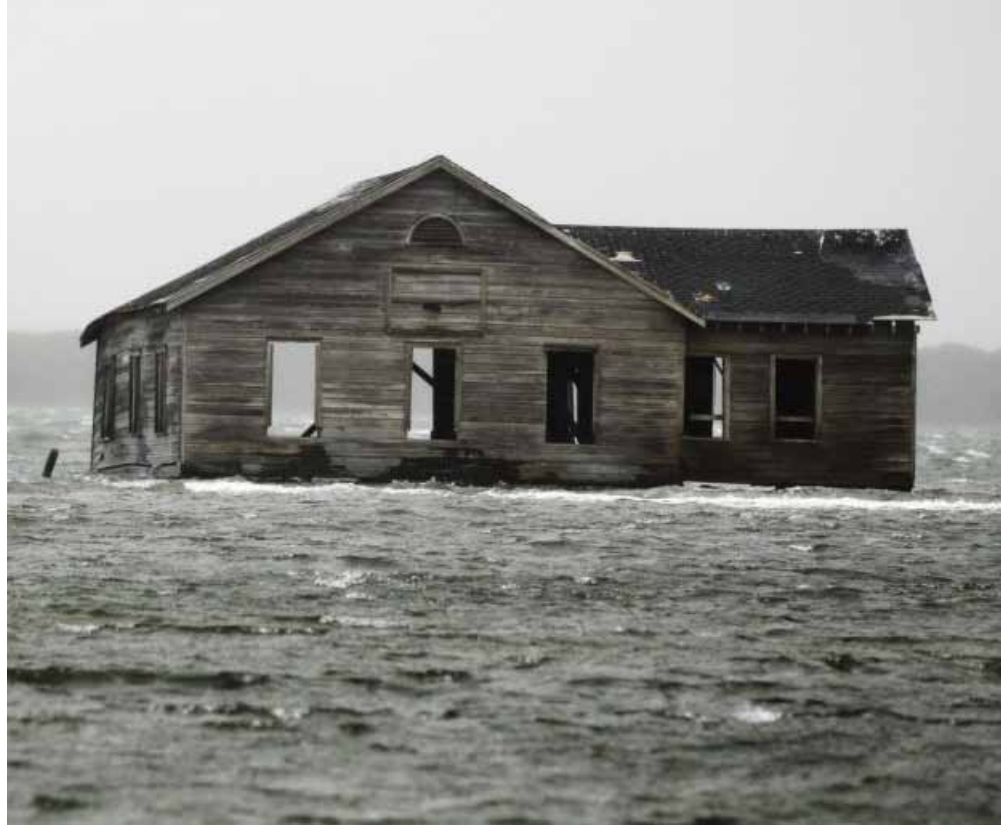
Esta vivienda de entramado ligero de madera, queda, después de un huracán, anegada por las aguas del mar
