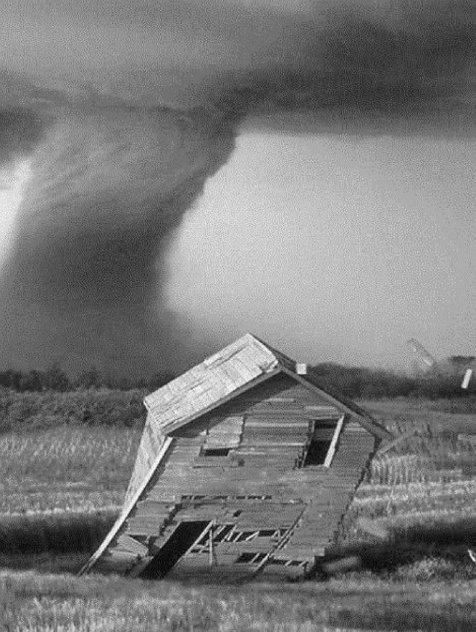
Impresionante el fenómeno del tornado y cómo esta vieja construcción de entramado ligero de madera -sin arriostramiento- se adapta a la presión del viento
