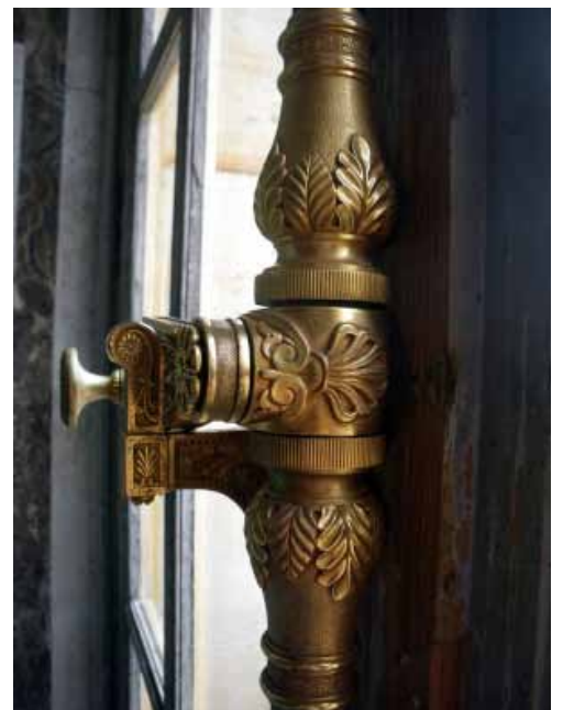
Maneta de falleba en el Palacio de Versailles. El palacio se construyó a finales del siglo XVII sin españoletas en los ventanales. Las magníficas fallebas/ españoletas de Pierre Gothière se incorporaron en el siglo XVIII, lo que prueba el retraso con que llegaron a Francia.
