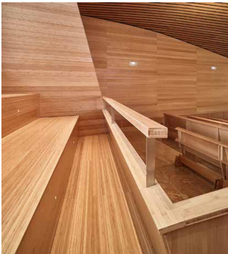
Barandillas y pasamanos de Tableros compuestos a base de laminar las chapas de bambú en diferentes posiciones y formatos
