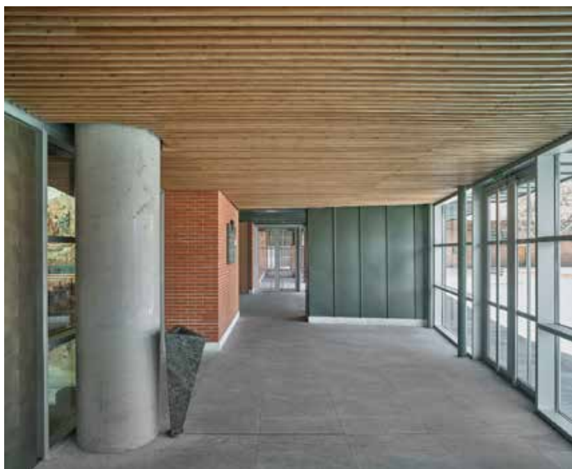
Los tableros laminados de bambú puestos de canto en el Hall de entrada al oratorio
