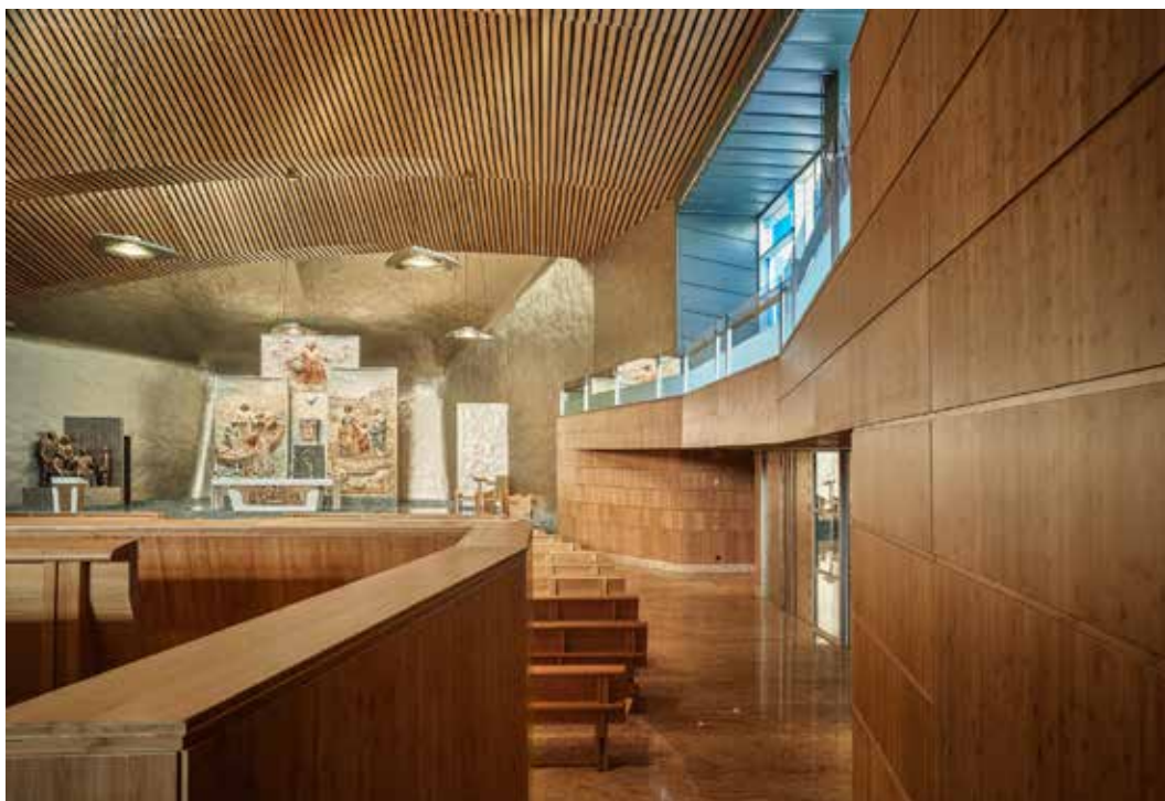
Zona de entrada del oratorio. Las paredes se revisten de placas de bambú en orientación vertical, con entrecalles de madera. Diseño del remate del peto del coro, de 19 y 40 mm de espesor, dejando un ranurado y un plafonado de borde.
