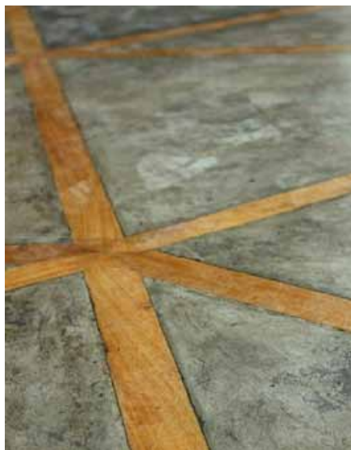
Suelo de hormigón pulido y madera
