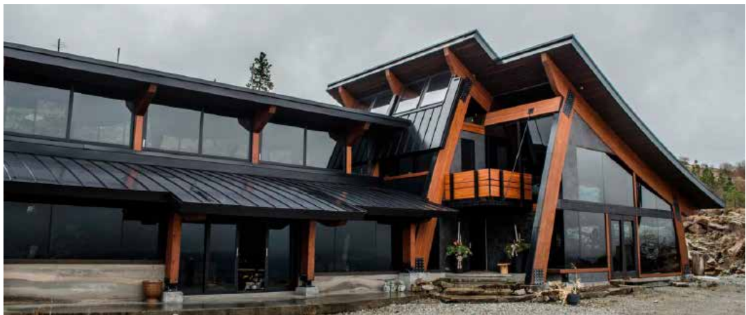
Vista principal de la vivienda
