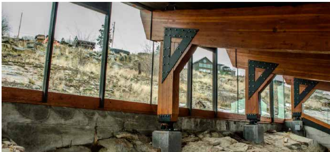
Los arcos de madera laminada se han colocado en sentido inverso al original
