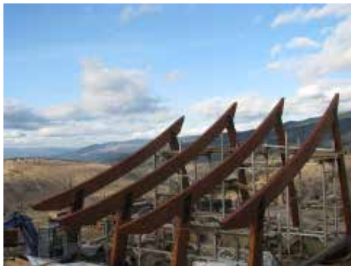
Montaje de la estructura principal con los pórticos donde se reutilizaron los arcos tanto en pilares como en vigas
