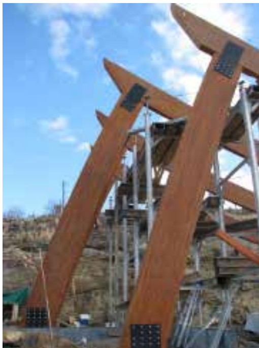
Montaje de la estructura principal con detalle de las uniones a base de placas perforadas y pernos
