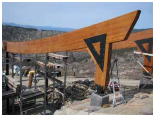
Montaje de la segunda fase
