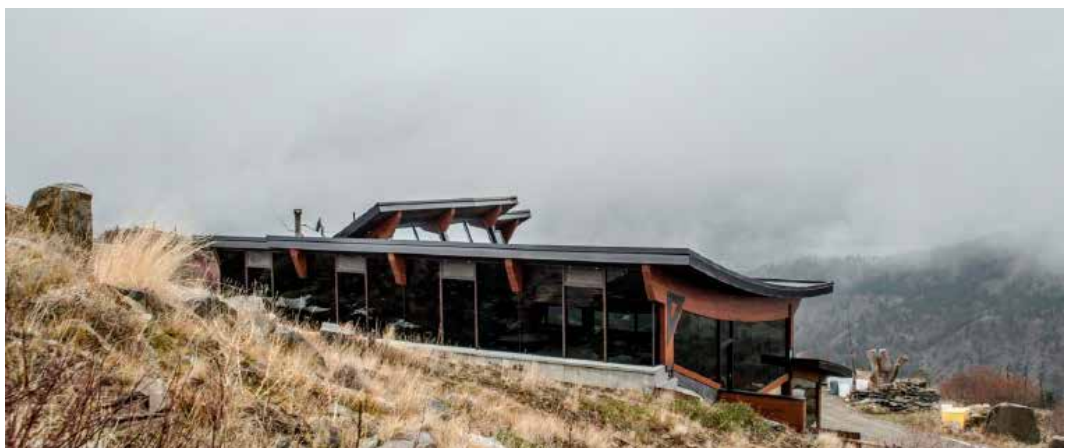
Vista posterior de la vivienda
