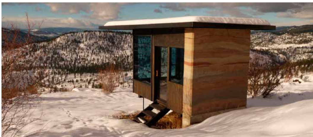
Soportando el invierno canadiense con techo y forjado de CLT reciclado
