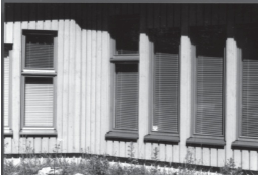
Perfiles colocados de canto para lograr una mayor delgadez del bastidor
