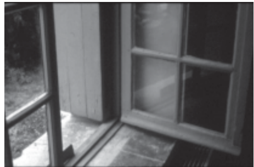
Perfiles curvos y parteluces en una ventana tradicional
