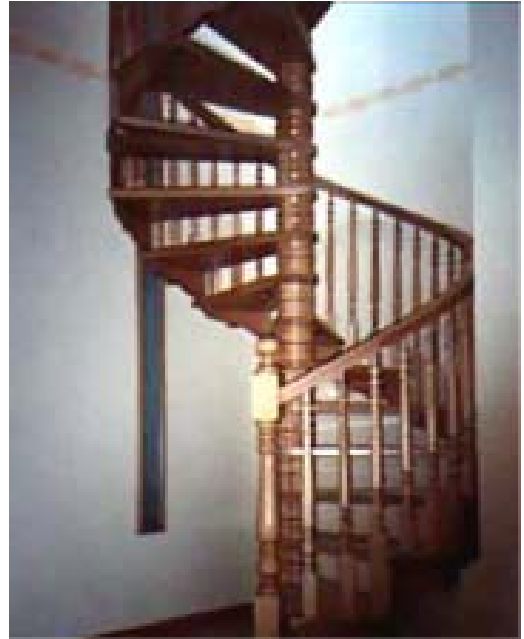
Peldaños radiales, tangenciales al núcleo
