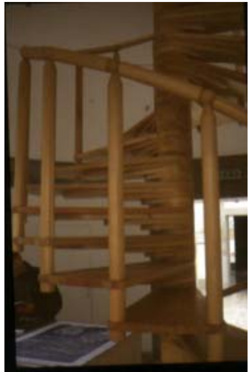
Escalera de caracol de núcleo central circular por apilamiento. Los peldaños son de madera laminada con perfil en voladizo
