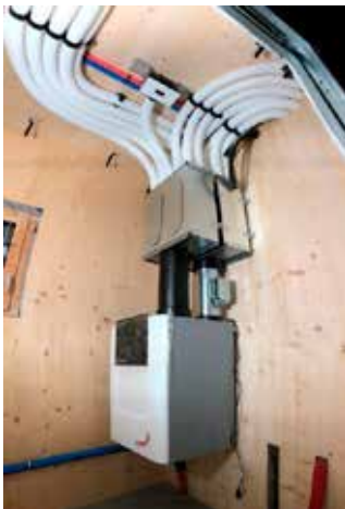
Recuperador de calor (con la batería eléctrica antes de los silenciadores), elementos de distribución y tomas.
