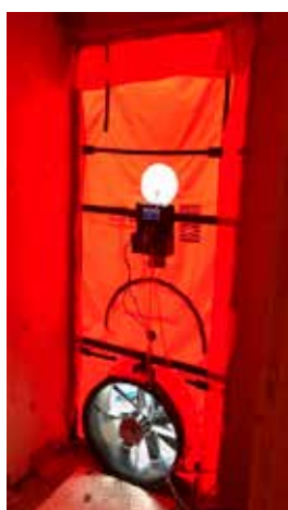
Prueba de blower-door
