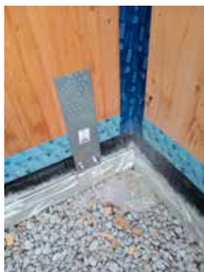
Elementos de hermeticidad en base de muros, juntas y fachada ventilada
