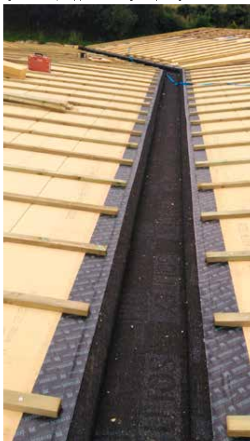
Colocación del aislamiento en cubierta, el rastrelado de la cámara de aire y el tablero de base para el zinc
