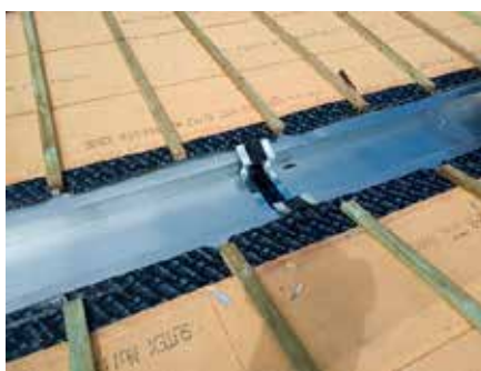
Elementos de hermeticidad en cubierta bajo la lámina de zinc
