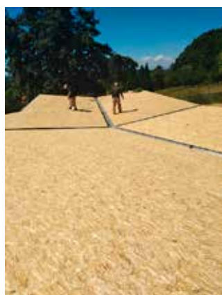
Colocación del aislamiento en cubierta, el rastrelado de la cámara de aire y el tablero de base para el zinc
