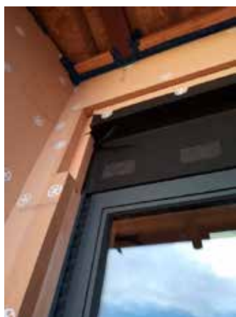
Colocación del aislamiento de fibra de madera en la base de los muros, encuentro con alero y con ventana
