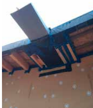
Colocación del aislamiento de fibra de madera en la base de los muros, encuentro con alero y con ventana
