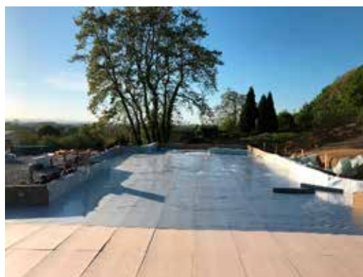
Cimentación a base de solera de hormigón armado
