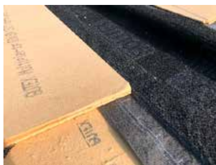
Elementos de hermeticidad en base de muros, juntas y fachada ventilada
