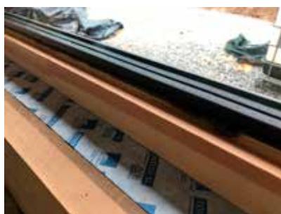
Elementos de hermeticidad en ventanas por interior y exterior
