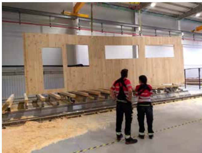
Imagen 2: Un panel de pared levantado en 2 puntos de anclaje laterales, a la salida del CNC de la planta de producción de Xilonor.
