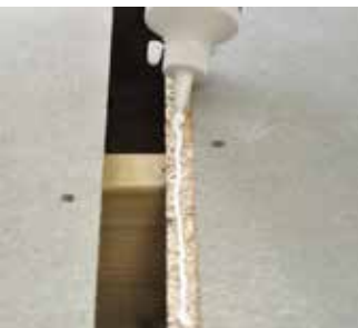
Encolado de la machihembra para que el tablero funcione como diafragma
