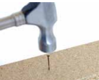
Clavado del tablero de partículas
