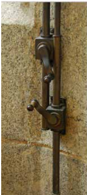
Las complejas y sofisticadas cerrajerías diseñadas por Lutyens en Castle Drogo a base de brazos articulados permiten la maniobra de ventanas situadas a una gran altura.
