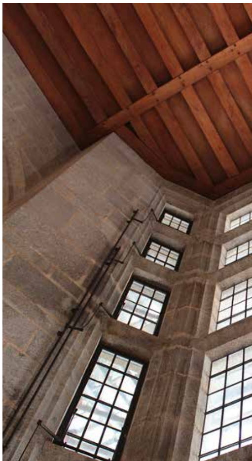
Cerrajería de muelles en la casa Bois des Moutiers (1898) diseñada por Edwin Lutyens para una carpintería de madera (a la izquierda su secuencia de maniobra)
