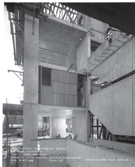
Fijación de los paneles de carpintería del Instituto Salk, de Louis I. Kahn
