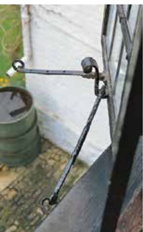
Retenedor de anilla y gancho que se fija al tirador (en este caso)
