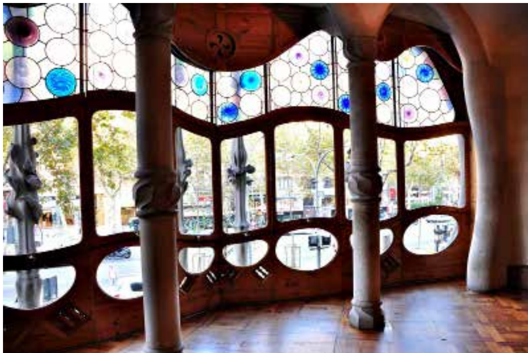
Interior de la tribuna de la casa Batlló donde se aprecian las guías de las ventanas de guillotina (sobre la parte superior (vidriera). En la parte baja se aprecian las aperturas de ventilación
