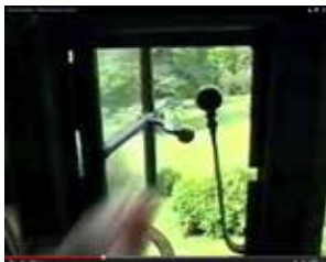
Cerrajería de muelles en la casa Bois des Moutiers (1898) diseñada por Edwin Lutyens para una carpintería de madera (a la izquierda su secuencia de maniobra)
