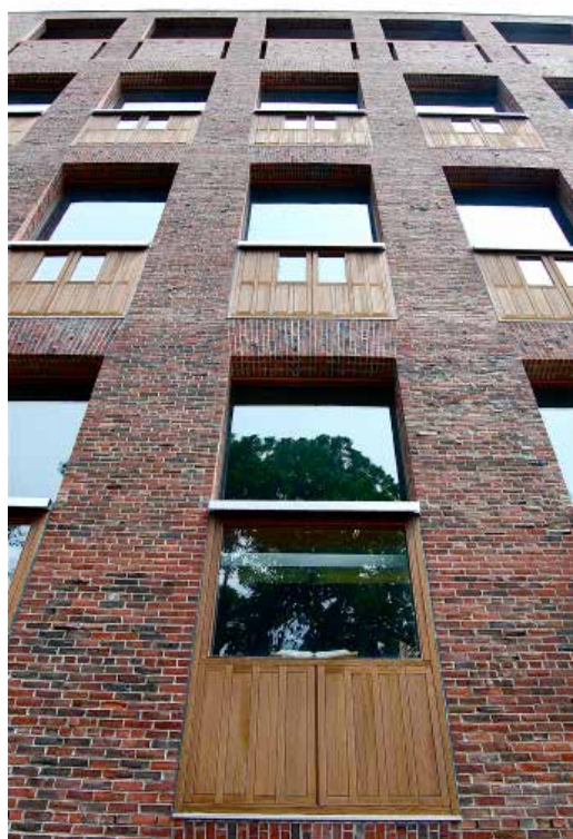
Louis I. Kahn. Carpintería exterior de la Biblioteca Exeter. Axonométrica de carpintería y exterior
