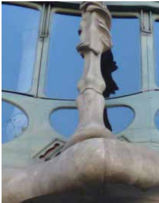
Guías de las ventanas de guillotina de la tribuna de la casa Batlló (Antonio Gaudí)
