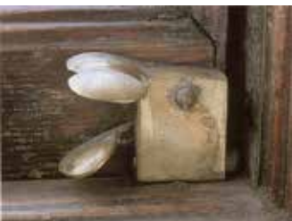
Herraje de fijación de ventana de guillotina utilizado en Casa Botines (Antonio Gaudí)
