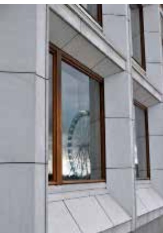
Alvar Aalto. Ventanas de madera de pino rojo del edificio Enso Gutzeit en Helsinki, 1962
