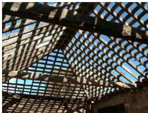
Estado original de la estructura de cubierta
