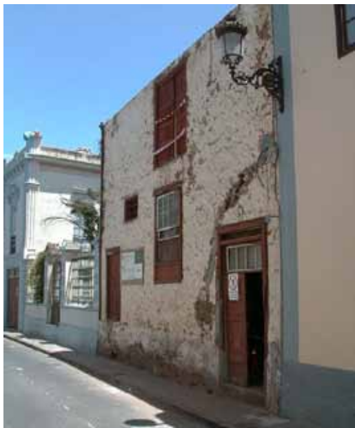
Recuperación de la carpintería exterior original excepto puerta de entrada y ventana de guillotina, con sustituciones parciales
