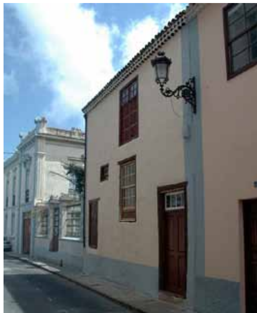
Recuperación de la carpintería exterior original excepto puerta de entrada y ventana de guillotina, con sustituciones parciales
