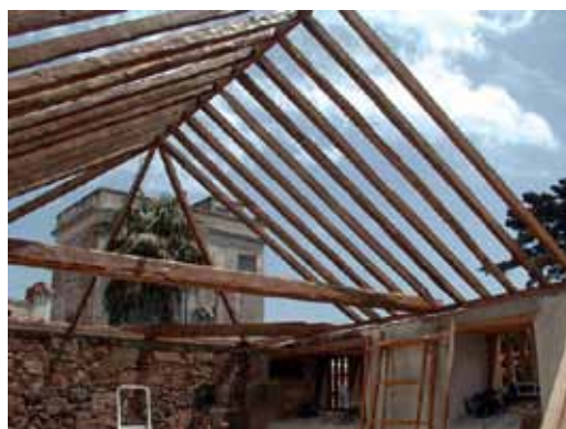
Colocación de los pares, cumbrera y tirantes originales
