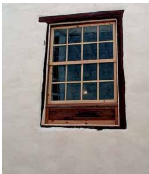
Recuperación de la carpintería exterior original excepto puerta de entrada y ventana de guillotina, con sustituciones parciales
