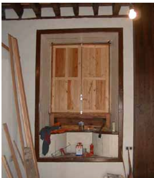
Recuperación de la ventana de guillotina con madera nueva y de derribo
