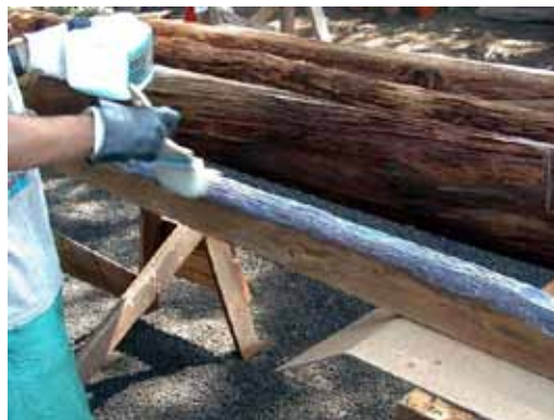
Acabado protector de la estructura de cubierta
