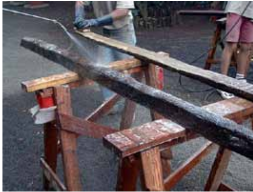
Limpieza de la estructura tras haberla desmontado
