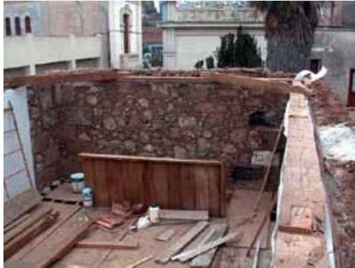
Colocación del durmiente para el apoyo de los pares
