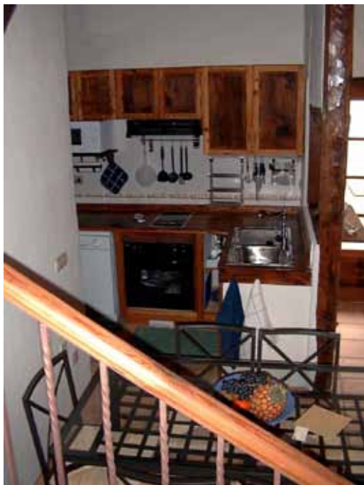
Para los plafones de los frentes de los muebles de cocina y de los armarios roperos se han utilizado igualmente los tablones de cerramiento del forjado, del siglo XVI. El resto de la estructura es tablero tricapa, de madera
