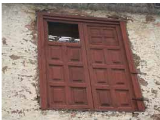
Recuperación de los postigos de la planta superior
