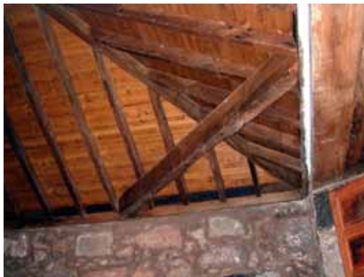
Colocación del panel sandwich
