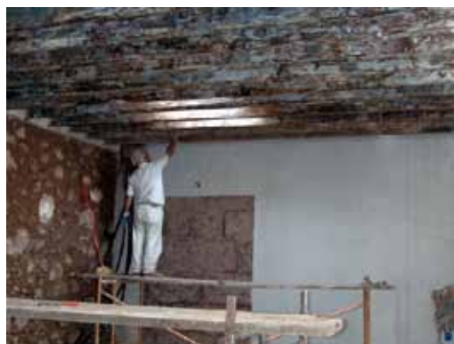
Limpieza de las viguetas de forjado sin desmontar
