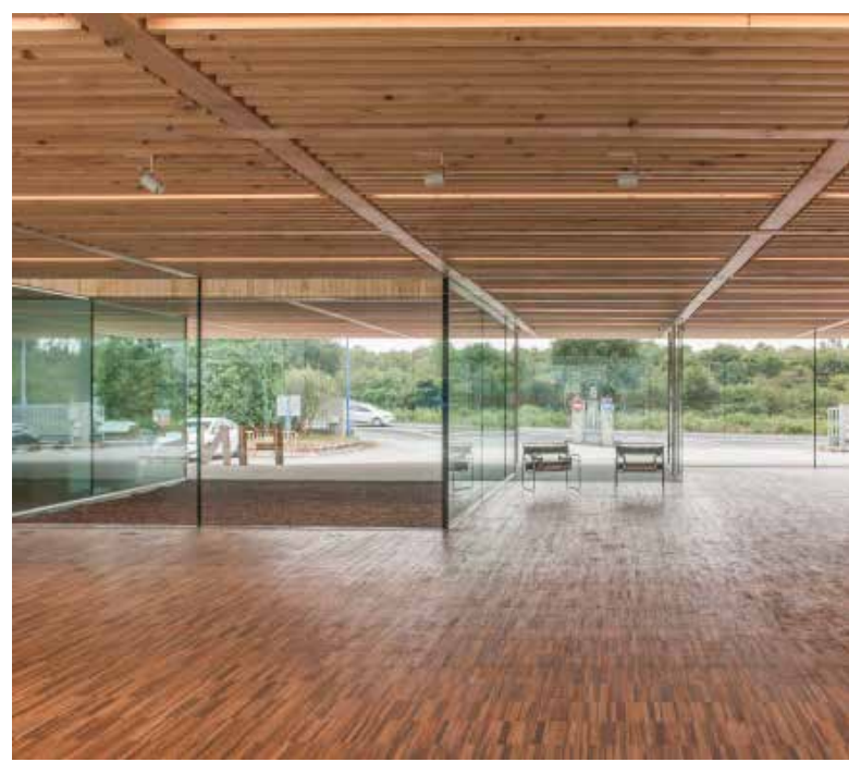
Techo formado por tableros MDF ignífugo de 16 mm al que se añade un lintoneado de pino acabado con ILVACRY Flamer oficinas centrales de FINSA
