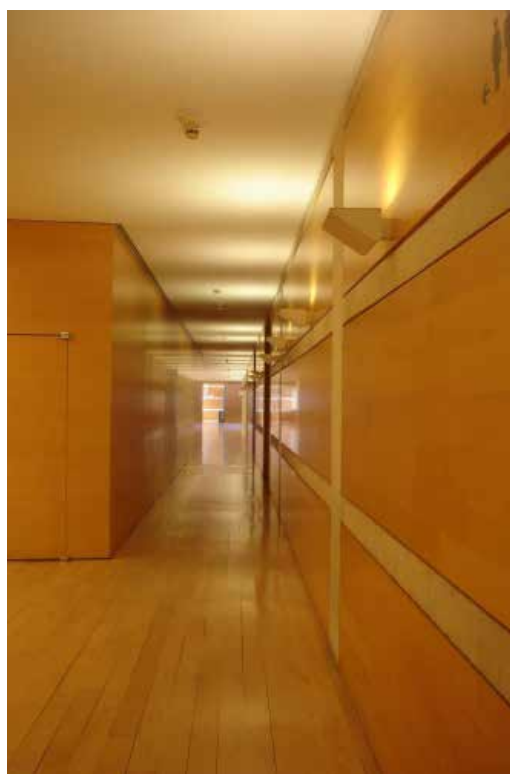
Paredes de contrachapado de Okume (antigua) M-1 de 19 mm rechapado en madera de arce americano con acabado retardante al fuego M-1 de poliuretano de dos componentes (LAuditori de Barcelona, Rafael Moneo, 1999)
