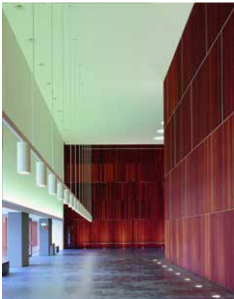
Entablado de Padouk de 140 x 22 mm sobre tablero MDF antigua M-1 con acabado retardante al fuego antigua M-1 (Baluarte, Patxi Mangado, 2003)
