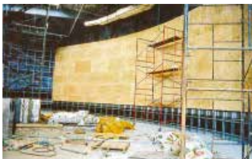
Formación de paredes con tablero contrachapado de abedul con Reacción al fuego antigua M1 en el Museo Guggenheim (Frank O. Gehry, 1997)
