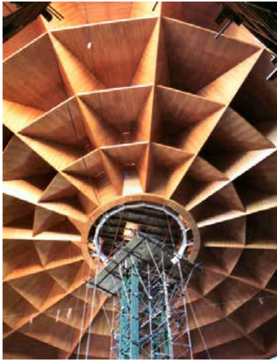
Techo de tablero de partículas con Reacción al fuego antigua M-1 de 19 mm rechapado en roble con acabado retardante al fuego (antigua)M-1 de dos componentes (Teatro de la Maestranza de Sevilla, Aurelio Pozo y Luis Marín, 1991)
