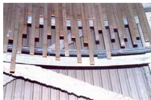
Instalación de las tablas de Ayous en el techo
