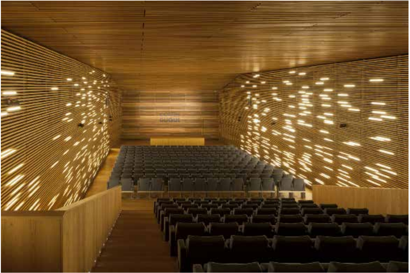
Paredes y techos es de roble macizo de 60 x 40 mm con tratamiento ignífugo en profundidad además de recibir un barniz de acabado retardante al fuego satinado (Salón de actos del Centro Conde Duque de Madrid, Carlos de Riaño Lozano, 2013. Carpintería: Mateca)
