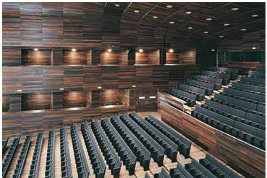
Revestimiento de tablero contrachapado con reacción al fuego mejorada y tablas de Wengé de 15 mm tratado al fuego. También los camones de madera de la sala está tratado para el fuego (Auditorio Ciudad de León, Tuñón y Mansilla, 2003)
