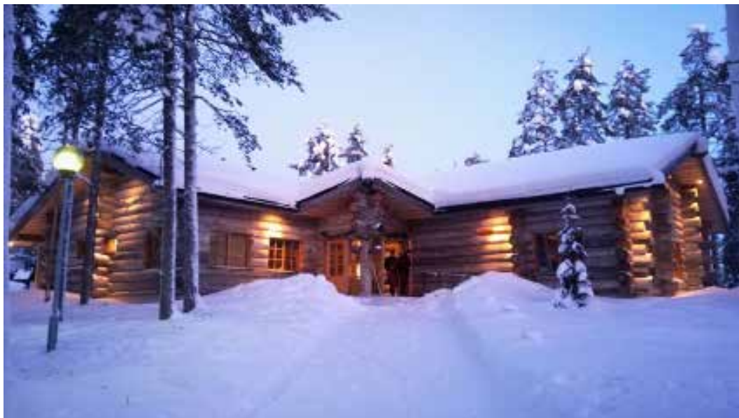
FIG 5_Construcción tradicional finlandesa_fuente Iñaki del Prim
