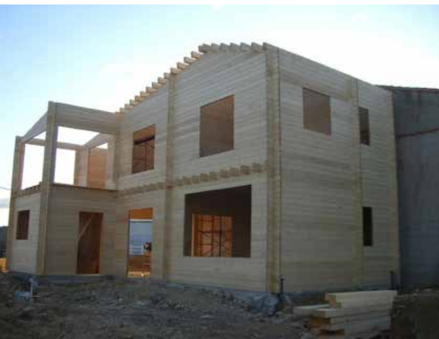
FIG 5_Construcción tradicional finlandesa_fuente Iñaki del Prim
