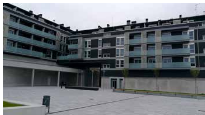
Fig. 6 Promoción de 65 viviendas en CLT de Hondarribia (Fuente Tecnalía).
