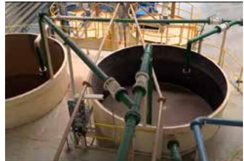
Tanques de mezclado de la celulosa en continuo movimiento © Wehrhahn GmbH
