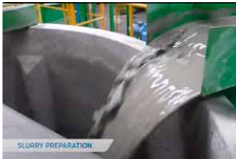
Preparación de la lechada o lodo cementoso MMFL
